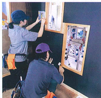
施工基本実習(クロス貼)
