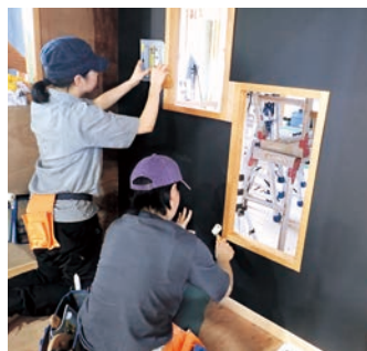
施工基本実習(クロス貼)
