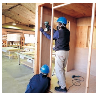
施工基本実習(下地組)
