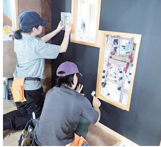
施工基本実習(クロス貼)
