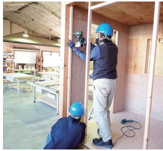
施工基本実習(下地組)
