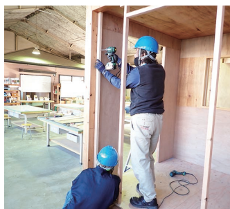
施工基本実習(下地組)
